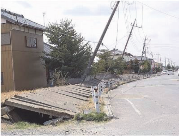
写真1. 潮来市（日の出地区）の液状化の発生状況の写真(H23.3.14)。激しい液状化が発生したことが分かる。
